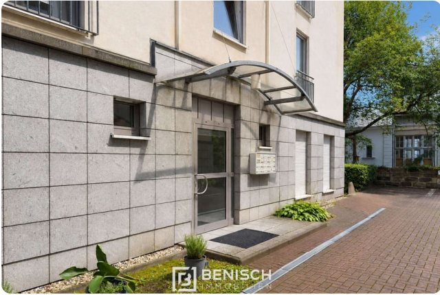
Eingangstür zum Gebäude
