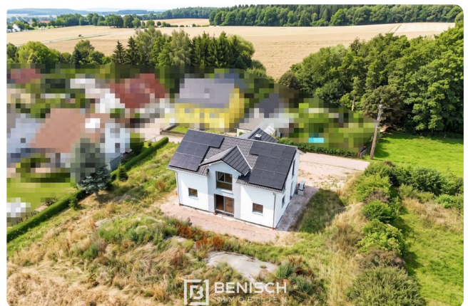
Photovoltaik auf dem Dach
