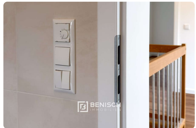
Regler Fußbodenheizung
