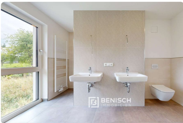
Doppelwaschbecken und Handtuchheizkörper im Bad im OG
