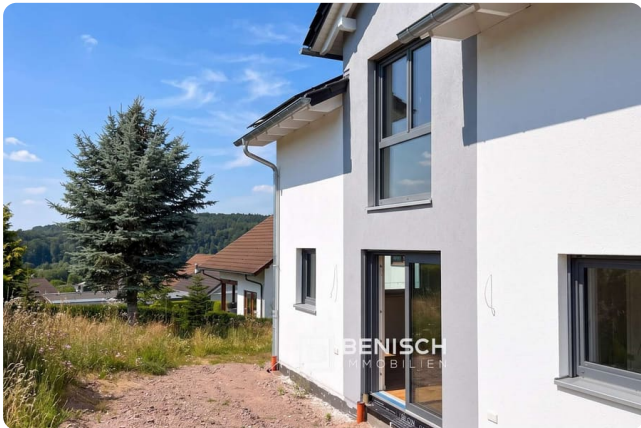
Blick auf die Hinterseite des Hauses
